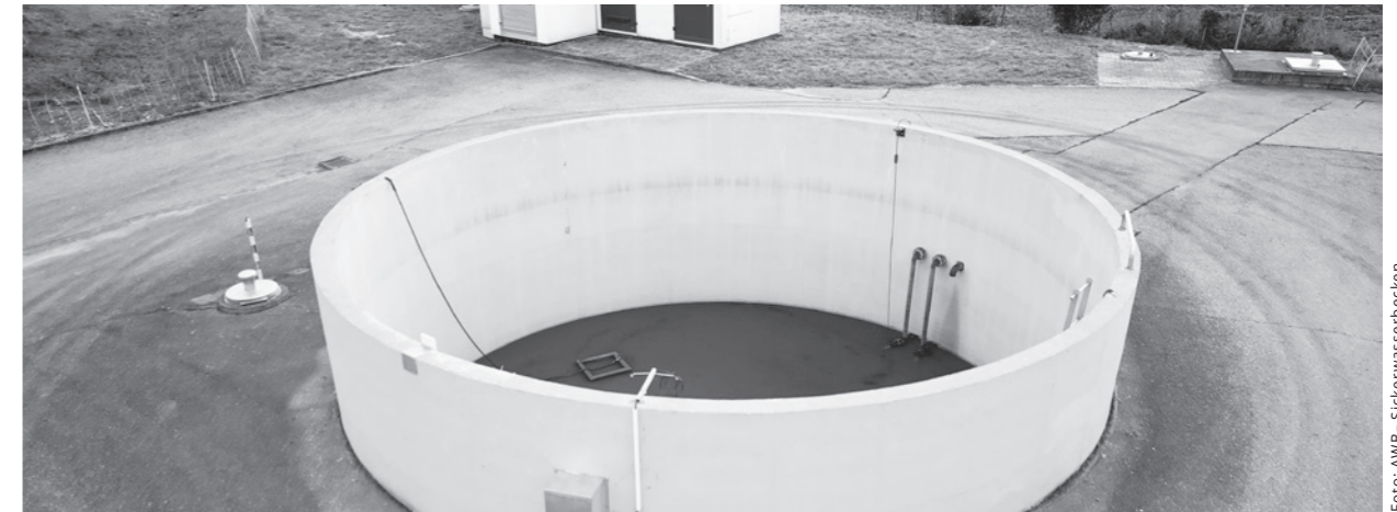
Foto: AWB - Sickerwasserbecken
