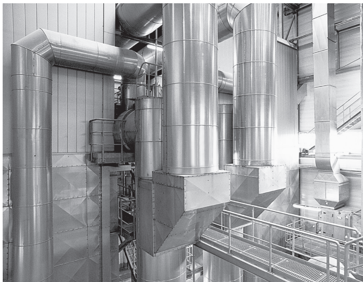
Foto: AWB – Blick auf den Gewebefilter
